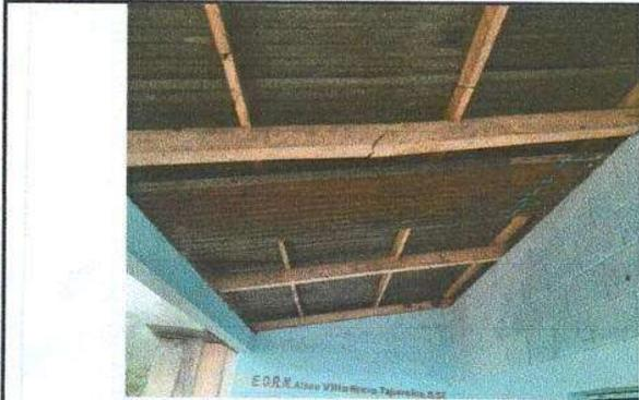
Foto 1: Sustitución de lámina, por lámina troquelada aluzinc calibre 26, Sustitucion de elementos de fijacion
